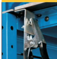
Крепление зажима заземления
