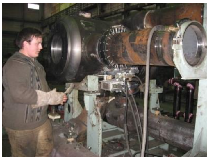
Рис.1 Внешний вид разнотолщинного сварного соединения и процесс сварки на комплексе «ПРОТЕУС» порошковыми проволоками типа POWER PIPE 60R.
